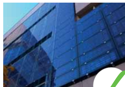
Épülethomlokzaton elhelyezett napelem megtervezett felülettel
