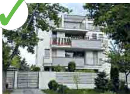
Új beépítés, jó épülettömeeggel
