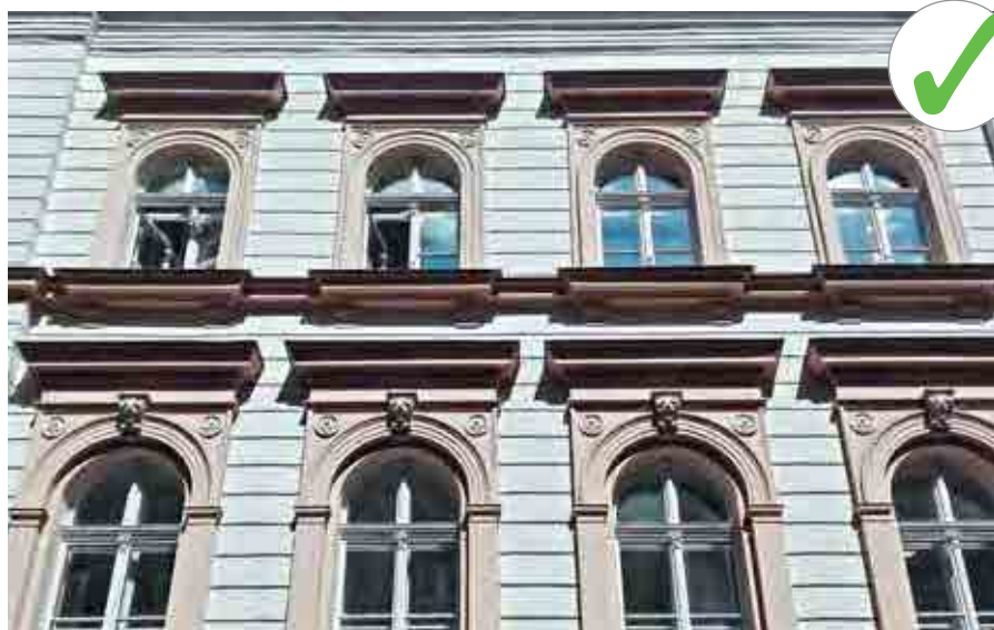
Szépén felújított homlokzat
