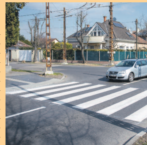
Az átjárókhöz csatlakozó járdafelületeket is átépítették
