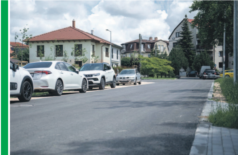
Az útfelújítás során megoldották a csapadékvíz-elvezetést, parkolókat építettek ki és rendezték a zöldfelületeket is
